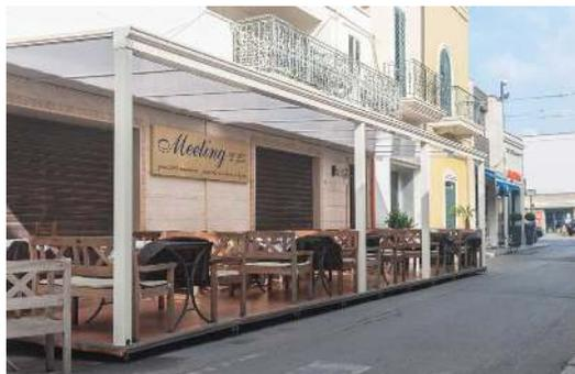
**La loro caratteristica è quella di poter essere fisse o apribili con la possibilità all'occorrenza di essere aperte a pacchetto. Le coperture possono essere realizzate in vetro, policarbonato compatto, policarbonato alveolare e pannello sandwich. Ognuna di queste soluzioni non intaccherà in alcun modo l'eleganza della struttura che si fonderà armoniosamente in un perfetto equilibrio estetico con l'edificio principale.**
